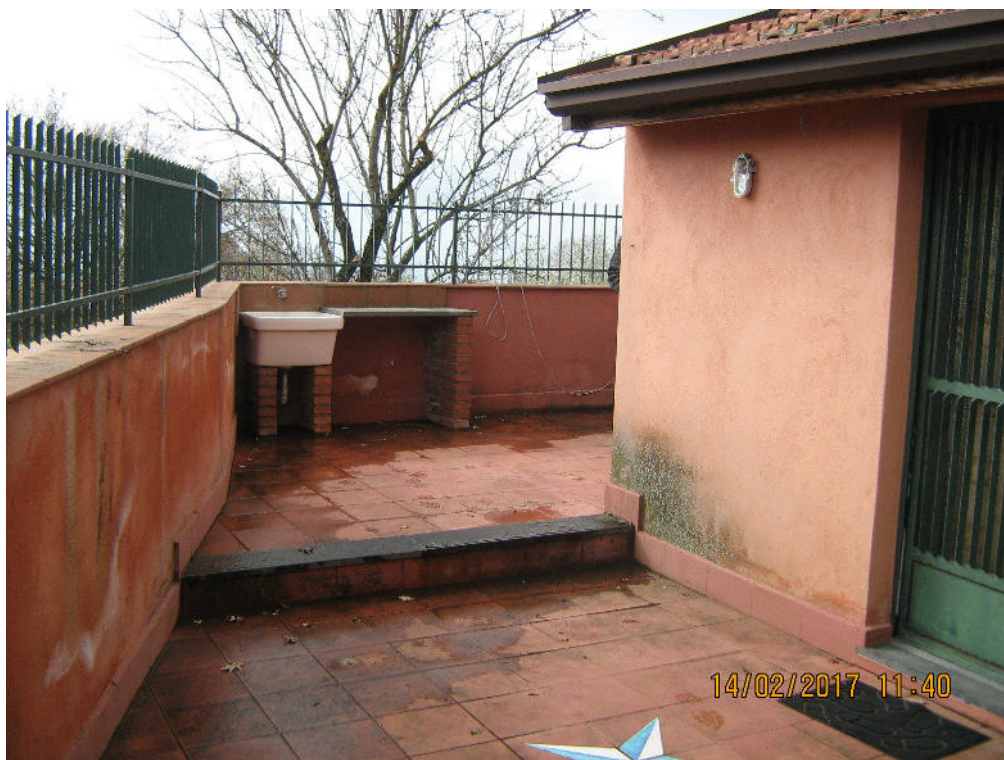
FOTO N.31 – TERRAZZO DAL 1° PIANO LATO OPPOSTO
