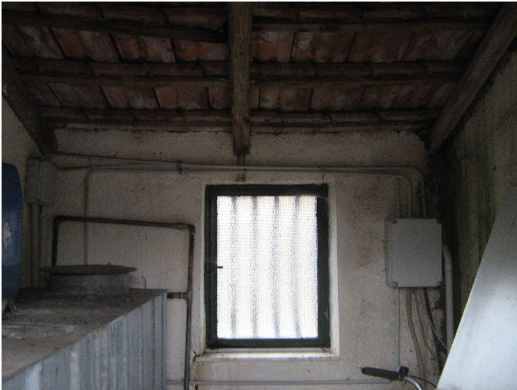
FOTO N. 6 –INTERNO RIPOSTIGLIO LATO SINISTRO
