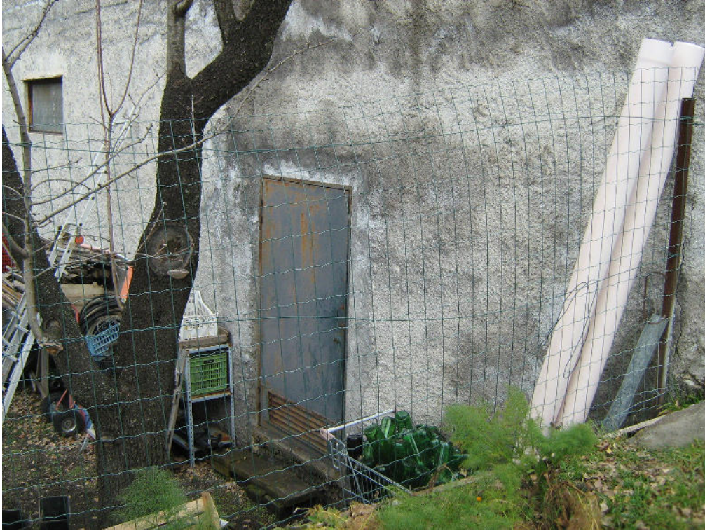
FOTO N.39 – RIPOSTIGLIO EX CISTERNA VISTA DA STRADELLA
