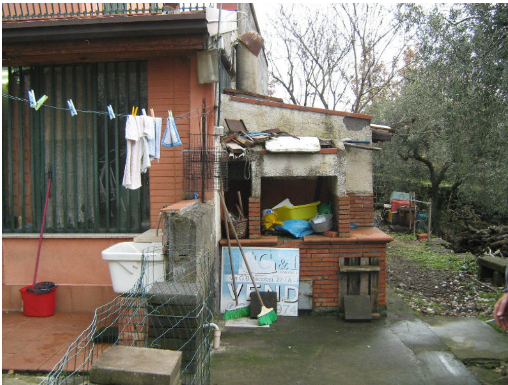
FOTO N.8 – FORNO IN PIETRA A CONFINE ED IN ADERENZA
