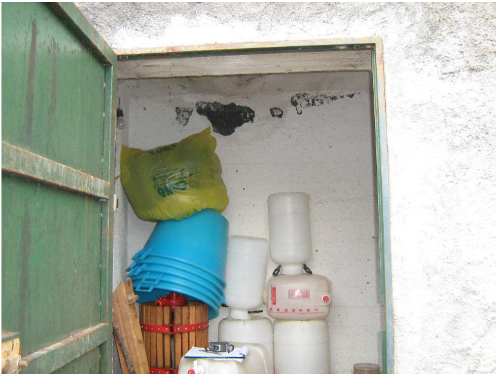
FOTO N.40 – RIPOSTIGLIO EX CISTERNA interno
