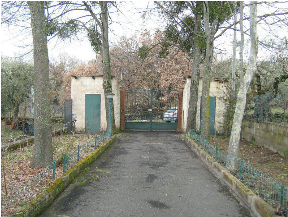
FOTO N.3 – INGRESSO VISTO DALL’INTERNO E RIPOSTIGLI
