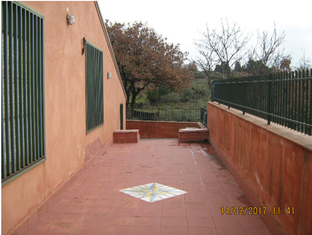
FOTO N.33 –TERRAZZO A PERIMETRO LATO OPPOSTO
